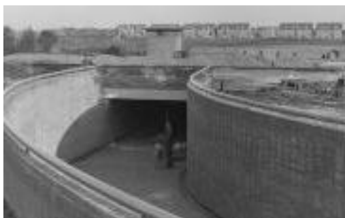
Aanleg van het fietstunneltje
