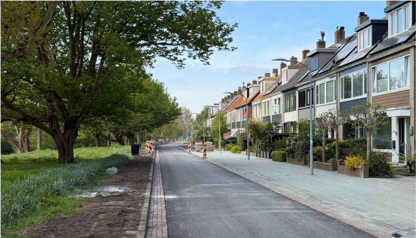
Basislaag asfalt, stoepen en verhoogde parkeerbestrating aangebracht in noordelijk deel van de Lodewijk van Deijssellaan
